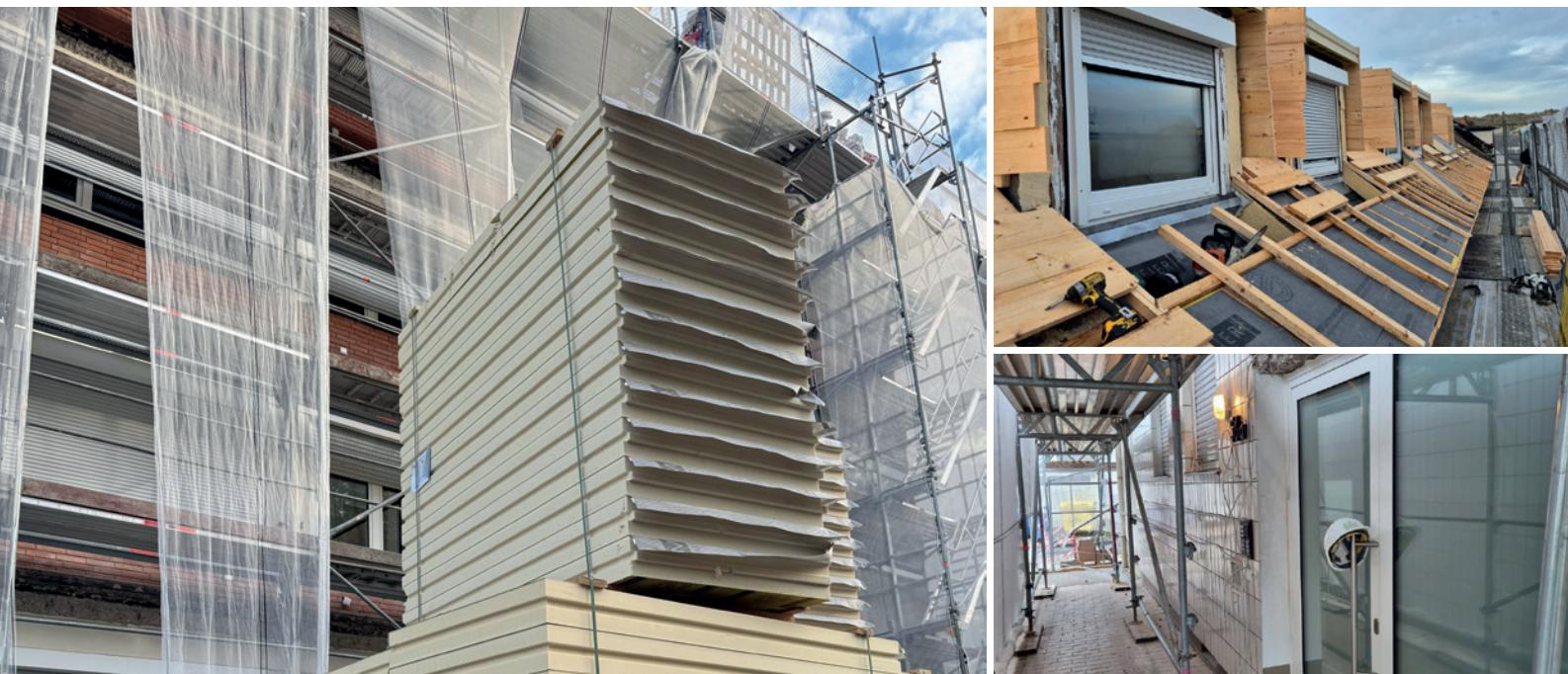
60er-Jahren hält viele Überraschungen bereit. Die Fassade wichen stellenweise bis zu vier Zentimeter in der Horizontalen von der Flucht ab, Fensterstürze lagen auf unterschiedlichen Höhen und die verbauten Fensterbänke in den Wohnungen variierten erheblich in den Abmessungen. Dadurch mussten kurzfristig Nachbestellungen und zahlreiche Anpassungen vorgenommen werden.
